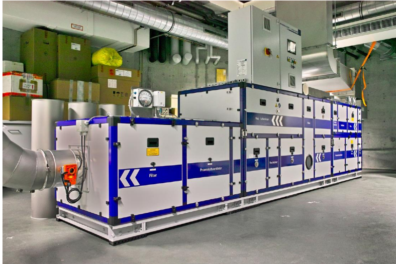
Abb. 6: Im Keller des Wolkenlabors befindet sich der Trockner zur Rekonditionierung des Durchflusses auf eine vorgegebene Taupunkt- und Luftvorlauftemperatur. Damit ist der Kreislauf komplett und der Zyklus wird erneut gestartet.
